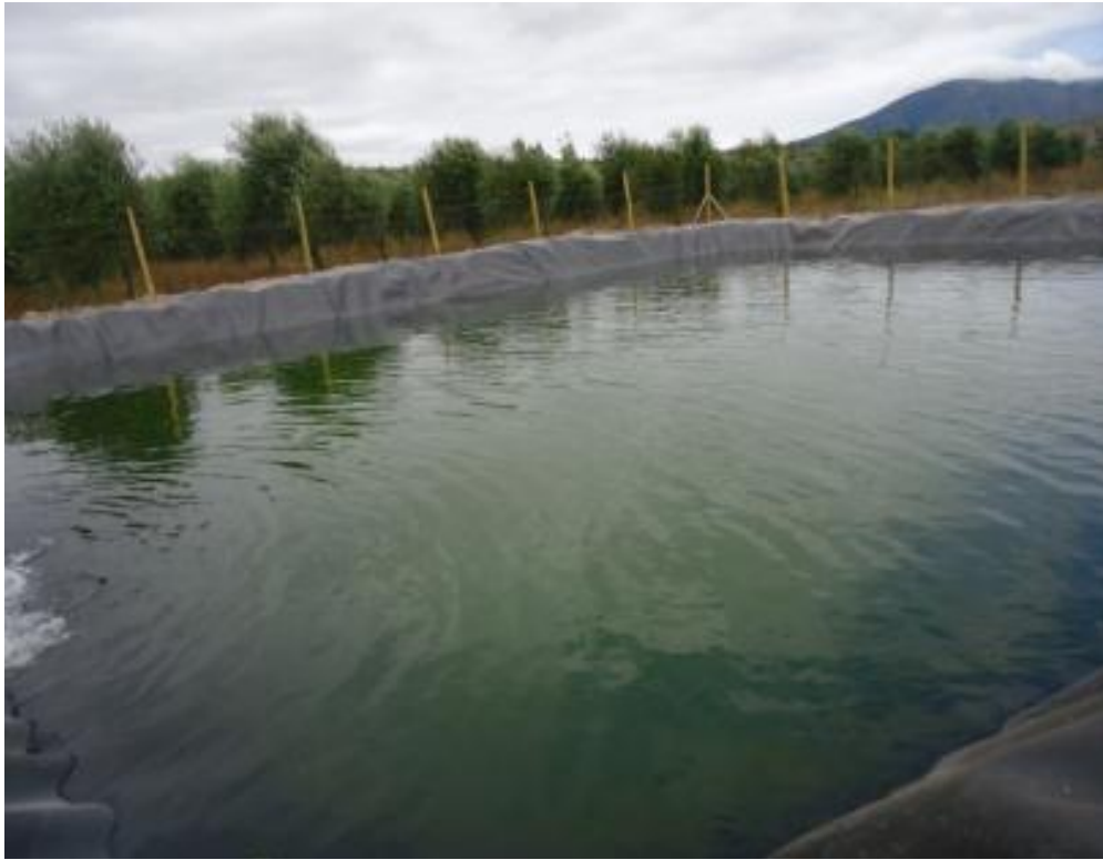
Imagen de acumuladores de agua, construidos con el apoyo Municipal a través del Servicio Prodesal de Papudo, a los pequeños agricultores, obras de riego que les permiten acumular recursos hídrico, obtenidos de pozos o punteras.
