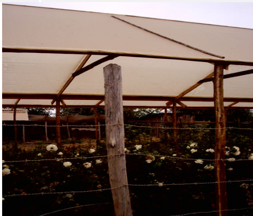
Foto N°10 Nave Alberto Hernández.
