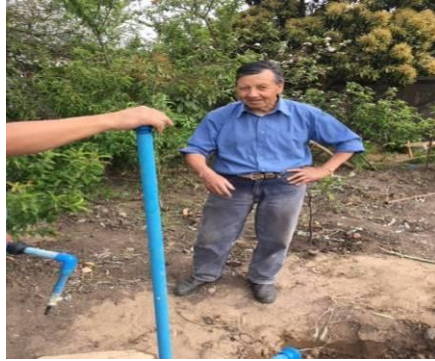
Foto N°6.- Instalación de aguas grises
