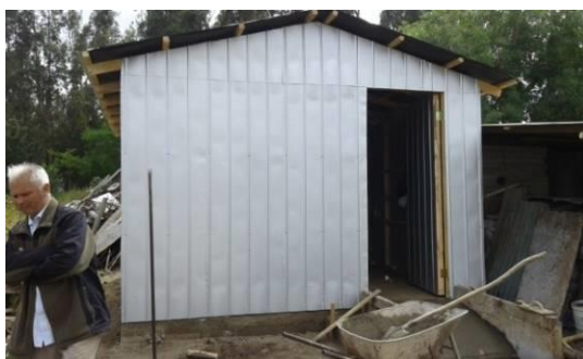
Foto N°12.- Construcción de Bodega de 20 mts
