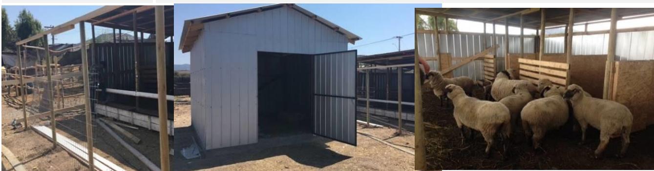
Foto N°13.- Ampliación de Corral y construcción de bodega
