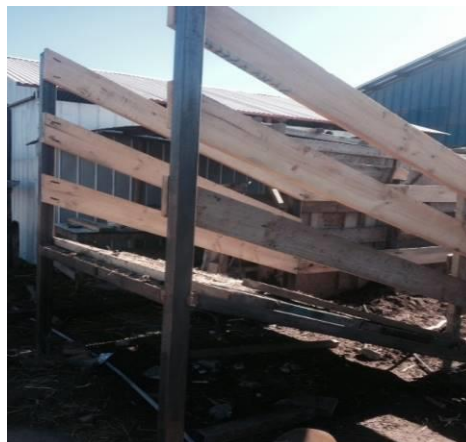
Foto N°10.- Adquisición de Pesa y Construcción de Cargadero
