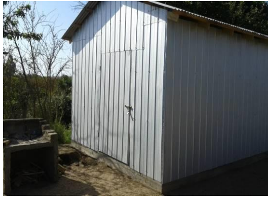
Foto N°8.- Construcción de Bodega y Invernadero de autoabastecimiento
