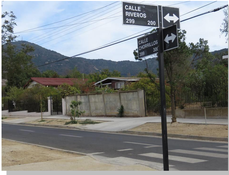
Imagen_ Construcción Pavimentación Calle Chorrillos, Papudo
