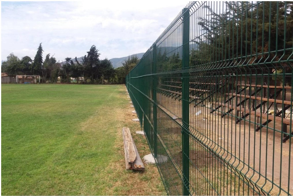
Imagen_ Cierre Perimetral Cancha Club Católica de Pullally
