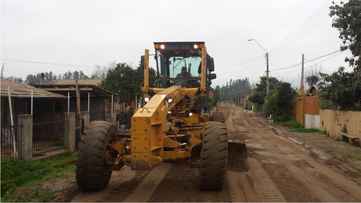
ARREGLOS CAMINOS DE LOCALIDAD PULLALLY.
