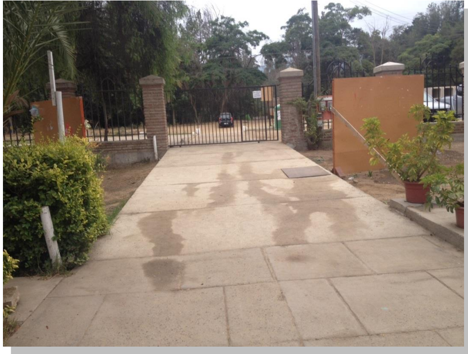
Imagen_ Construcción Sistema de Impulsión Aguas Servidas Escuela de Pullally
