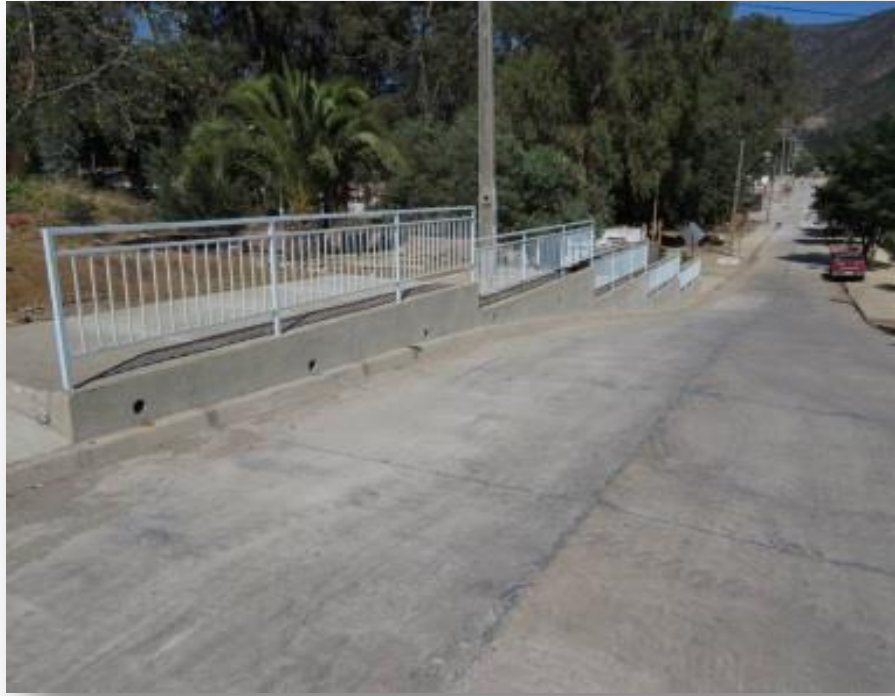
Imagen_ Construcción Pavimentación Calle Serrano, Papudo
