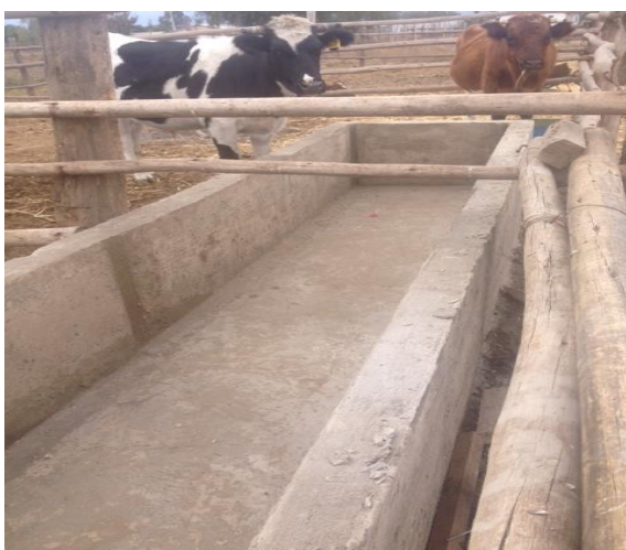
Construcción de Abrevaderos: Rosa Pizarro Báez
